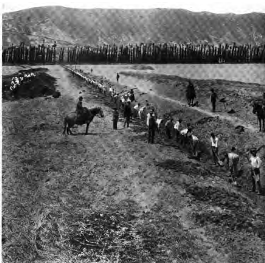
OPERAI AL LAVORO DI UNO SCASSATO.
